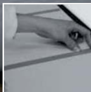
Pose du double-face
